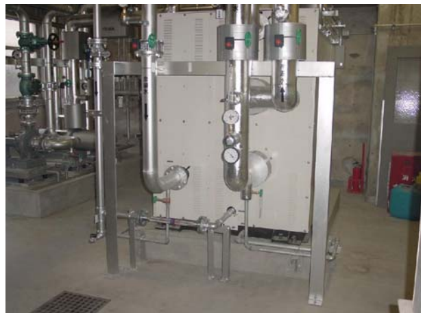
改修後の機械室内部
